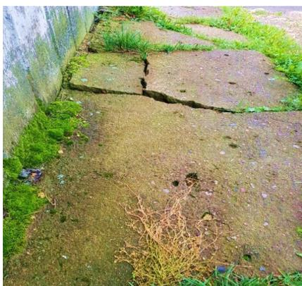
Рис. 2 – Разрушение отмостки здания
