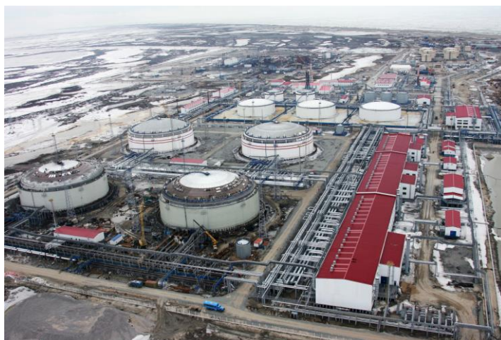
Рис. 1 – Береговой резервуарный парк Варандейского терминала
