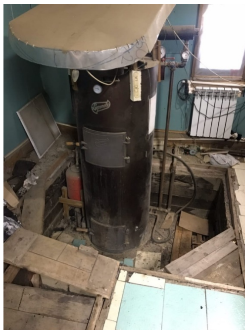
Рисунок 1 – Твердотопливный котел «Lierpsnele» мощностью 20 кВт, установленный в частном доме микрорайона г. Якутск
